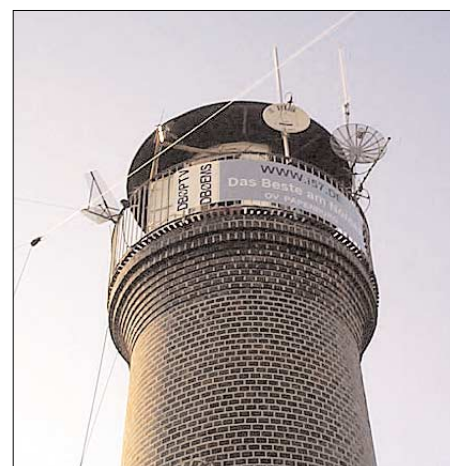
Der Leuchtturm – gespickt mit etlichen Antennen
